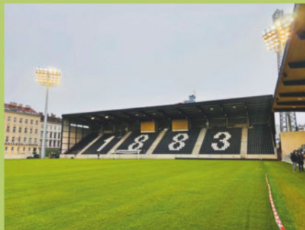
Die südliche Tribüne im Wiener-Sport-Club-Stadion erstrahlt nach einer Sanierung. DER STANDARD
