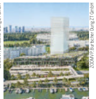
Betrieb ab 2029 geplant.
